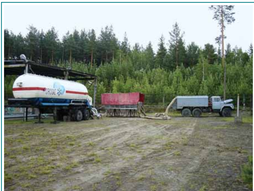
Ремонт газопровода без прекращения подачи газа потребителям
