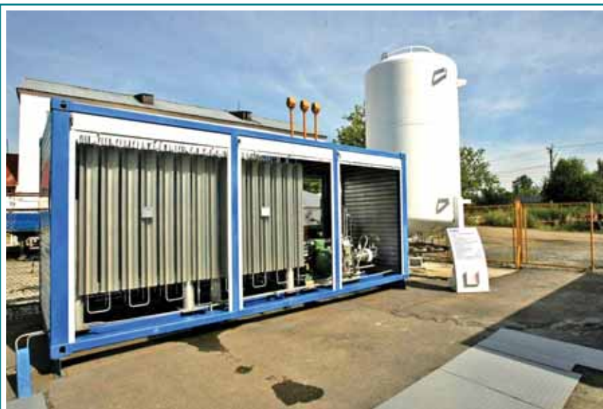
Комплекс для заправки 100 автомобилей в сутки СПГ или газифицированным КПГ
