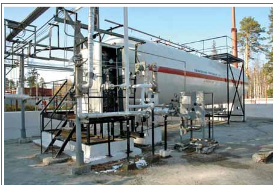
Комплекс хранения и регазификации на оздоровительном комплексе «Озеро «Глухое»
