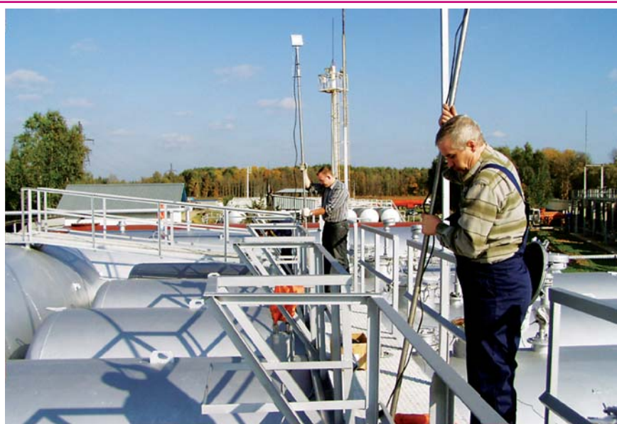
Рис. 5. Монтаж измерительных систем «СТРУНА» на объекте
