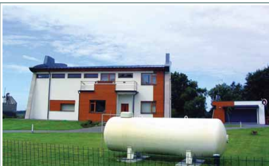
Рис. 1. Наземный резервуар для газоснабжения СУГ индивидуального коттеджа
