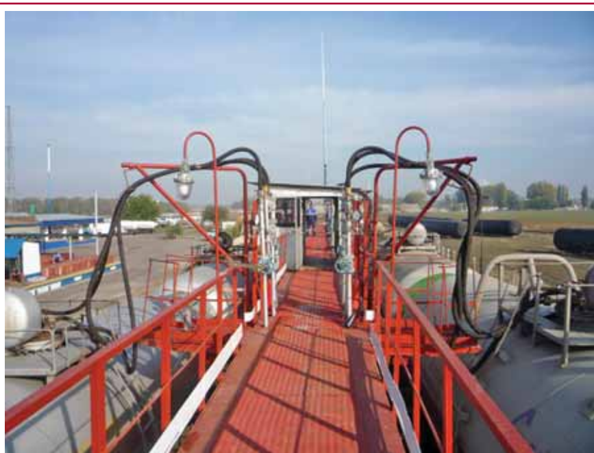
Рис. 4. Общий вид операции перегрузки СУГ с помощью резиноканевых шлангов
