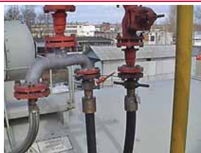
Рис. 3. Конструкция сливно-наливных устройств, оснащенных резиноканевыми шлангами
