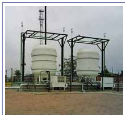
Рис. 6. Хранилище СПГ с резервуарами на основе экранно-вакуумной теплоизоляции
