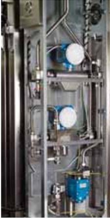
Рис. 2. Конструкция газораздаточной колонки ADAST 4700/CNG
