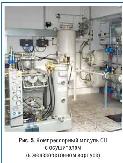
Рис. 5. Компрессорный модуль CU с осушителем (в железобетонном корпусе)
