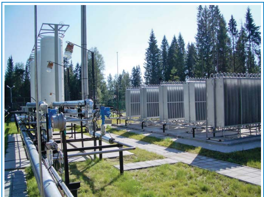
Система приема, хранения и регазификации СПГ в Игоре (Ленинградская обл.)
