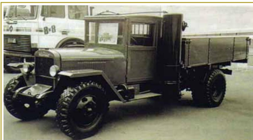
Рис. 4. «УралЗИС-5» с газогенераторной установкой
