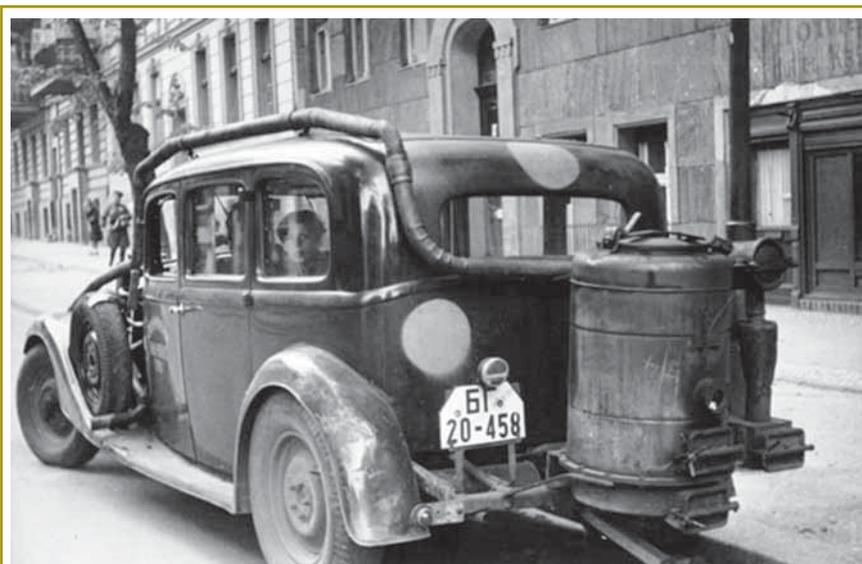
Рис. 3. Газогенераторный легковой автомобиль
