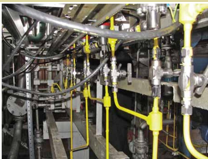
Система бесварных соединений труб
