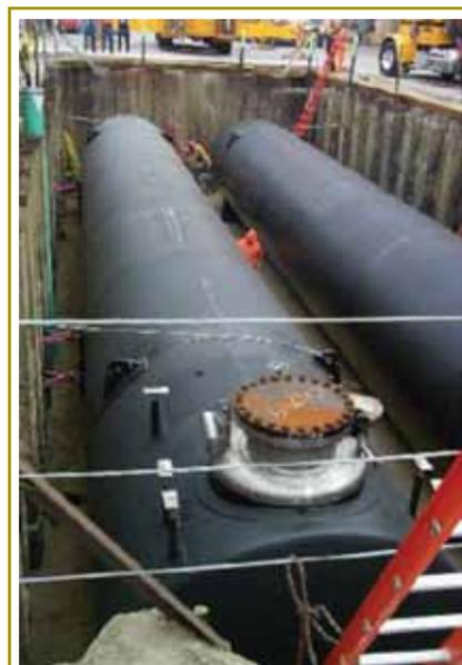
**Рис. 1.** Схема размещения и монтаж подземных горизонтальных резервуаров СПГ на заправочной станции для автомобильного транспорта
