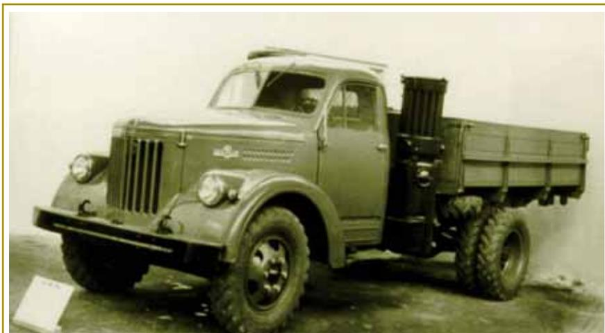
Рис. 5. Газогенераторный «ЗиС-21»
