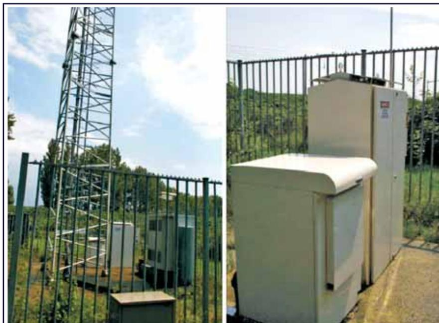
Рис. 11. Система резервного питания ретранслятора от энергоустановки на топливных элементах в г. Дордрехт [25]
