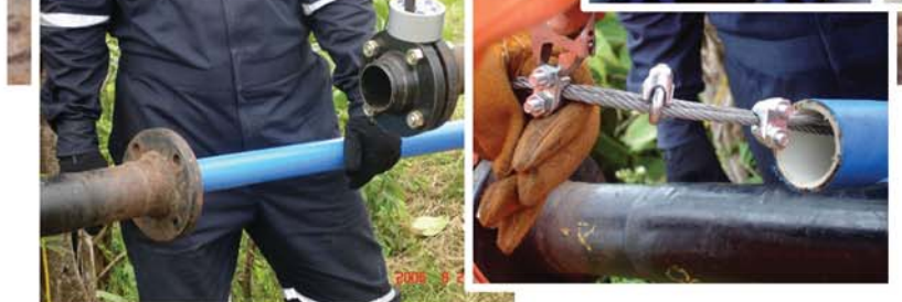
Рис. 6. Монтаж термопластиковых трубопроводов на АГЗС
