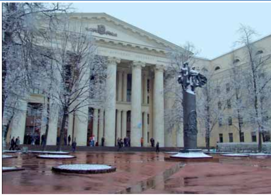
Главный корпус МАДИ
