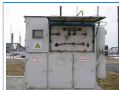
Рис. 1. Компрессорный блок действующей МКЗ-50У
