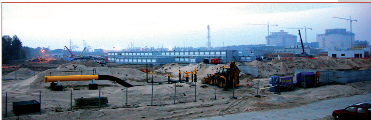
Строительство приемного терминала СПГ в Свиноустье (Польша, октябрь 2013 г.)
