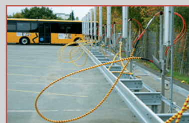
Рампа медленной заправки КПП в автобусном парке Фредерисии, Дания
