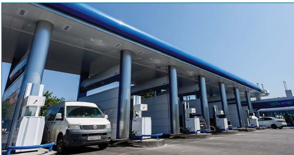
Реконструированная АНГКС «Газпром» в Ростовской области
