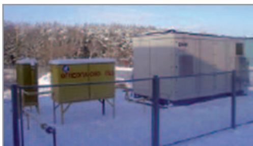
Рис. 15. Первая в России энергетическая установка PC-25™ на ФКТЭ на промышленной площадке организации ОАО «Газпром»
