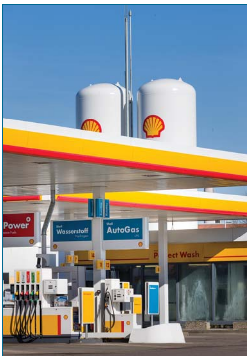
Водородная станция «Шелл» в Гамбурге (Германия), открытая 16 марта 2015 г. Водород производится на месте с помощью электролиза и хранится в двух объёмных резервуарах
