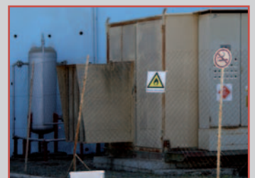
Переоборудованный на КПП автобус Van Hool; блочно-контейнерная АГНКС Nouvo Pignone 1996 г.
