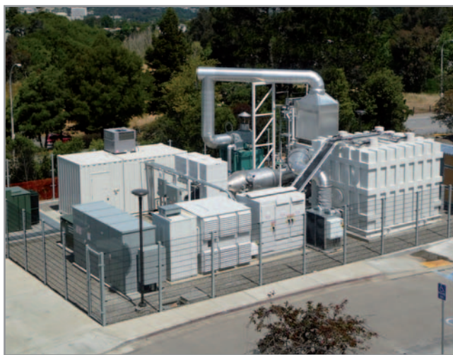
Рис. 23. Установка DFC1500 компании FuelCell Energy мощностью 1,4 МВт
