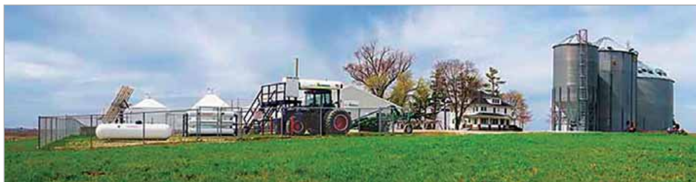
Рис. 12. Проект Solar Hydrogen System: слева солнечные панели и оборудование для производства аммиака; в центре – трактор, работающий на водородно-аммиачной топливной смеси
