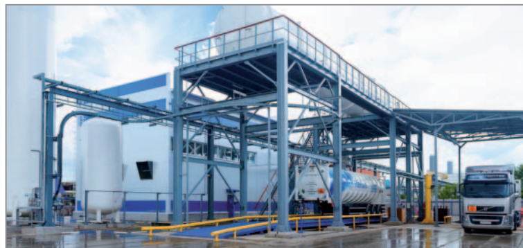
Технологический блок по отгрузке жидкого гелия
