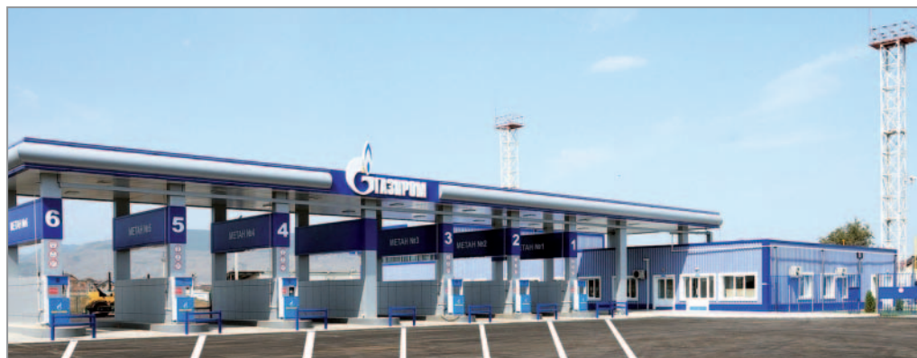
АГНКС ООО «Газпром трансгаз Махачкала», реконструкция в 2012 г.
