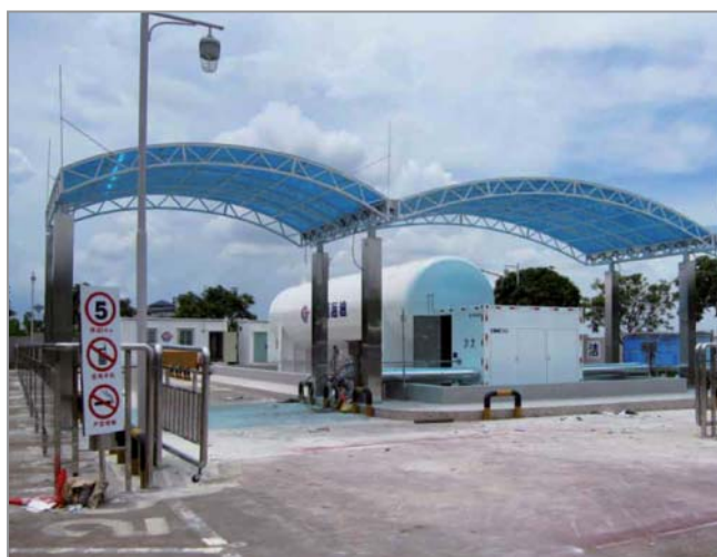
Рис. 4. Внешний вид автозаправочной станции с резервуаром СПГ объемом 60 м 3 , одним насосом и двумя заправочными постами в г. Жоншанге (Китай)
