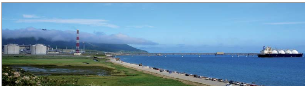
Сахалинский завод по производству СПГ
