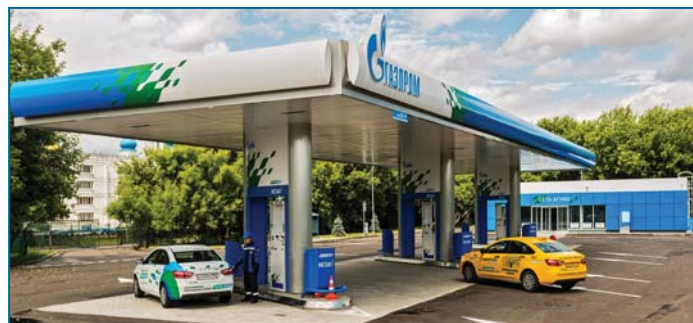
АГНКС «Газпром» на ул. Полбина в Москве
