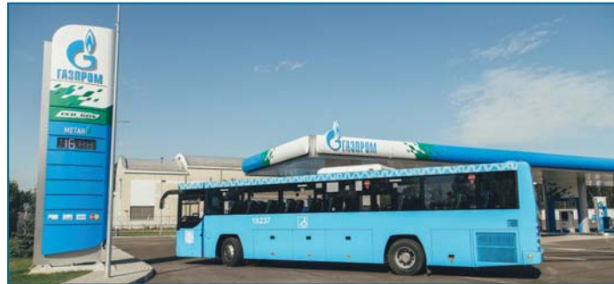
АГНКС «Газпром» на ул. Левобережная в Москве
