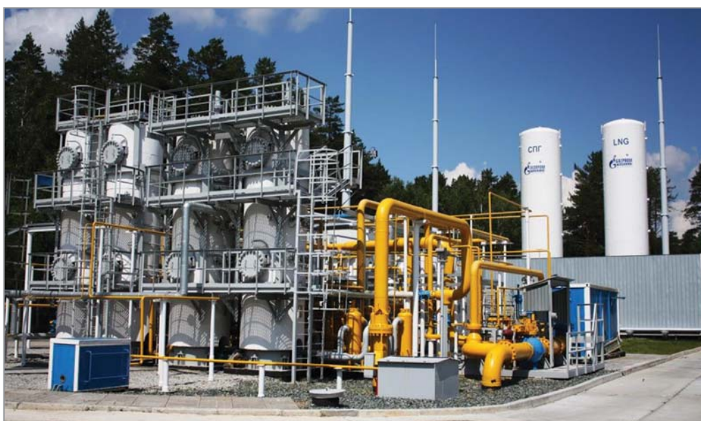
Рис. 3. Комплекс производства СПГ на ГРС-4 в Екатеринбурге
