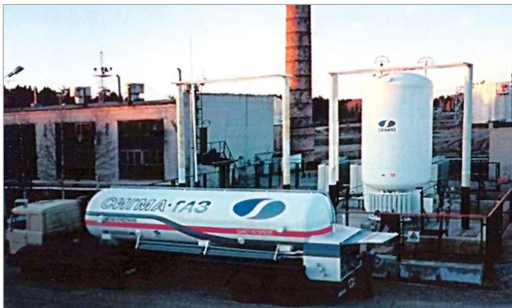
**Рис. 2.** Внешний вид комплекса автономного газоснабжения сжиженным природным газом котельной мощностью 3,5 МВт в Ленинградской области
