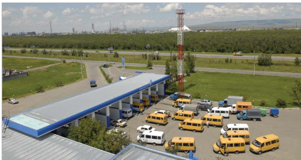
Рис. 1. Автомобильная газонаполнительная компрессорная станция (АГНКС) ООО «Газпром трансгаз Ставрополь»
