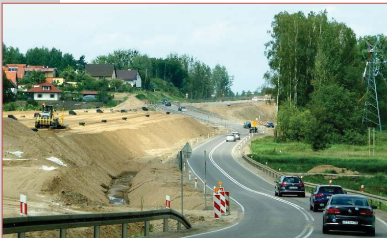
Строительство новых дорог в Польше
