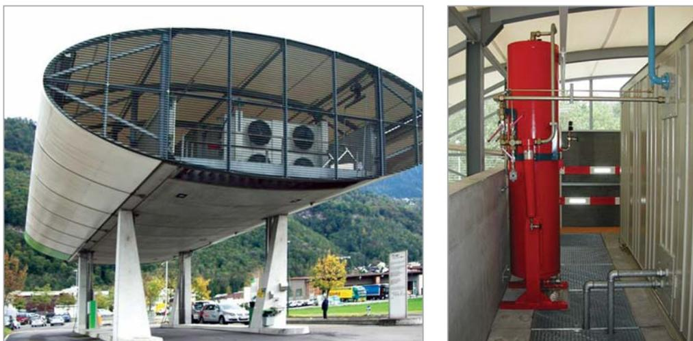
**Рис. 4.** Внешний вид АГНКС в Вадуце (Лихтенштейн). Технологическое оборудование размещено на верхнем уровне
