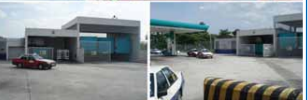
Рис. 32. На многотопливной АГНКС в г. Куала-Лумпур (Малайзия), газоснабжение осуществляют ПАГЗы
