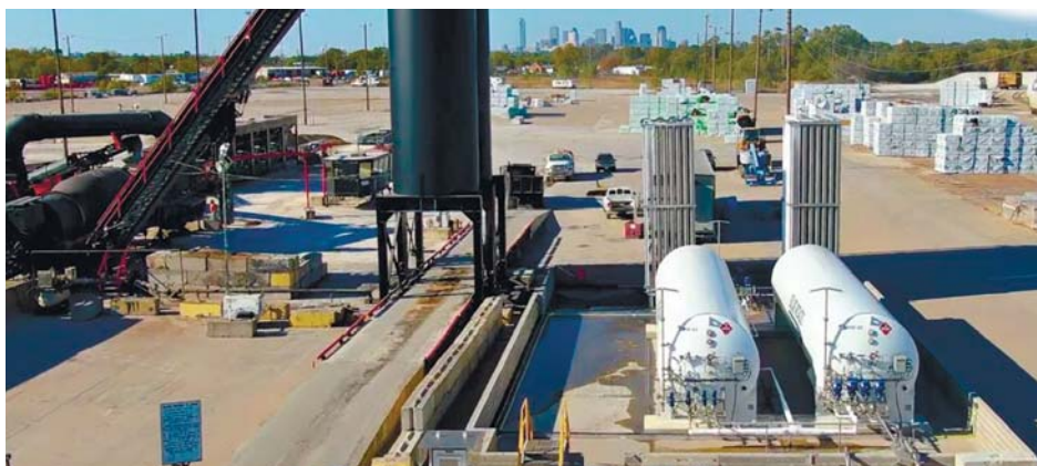
Модуль автономной газификации CNG Delivery («виртуальная труба») для асфальтового завода в Техасе
