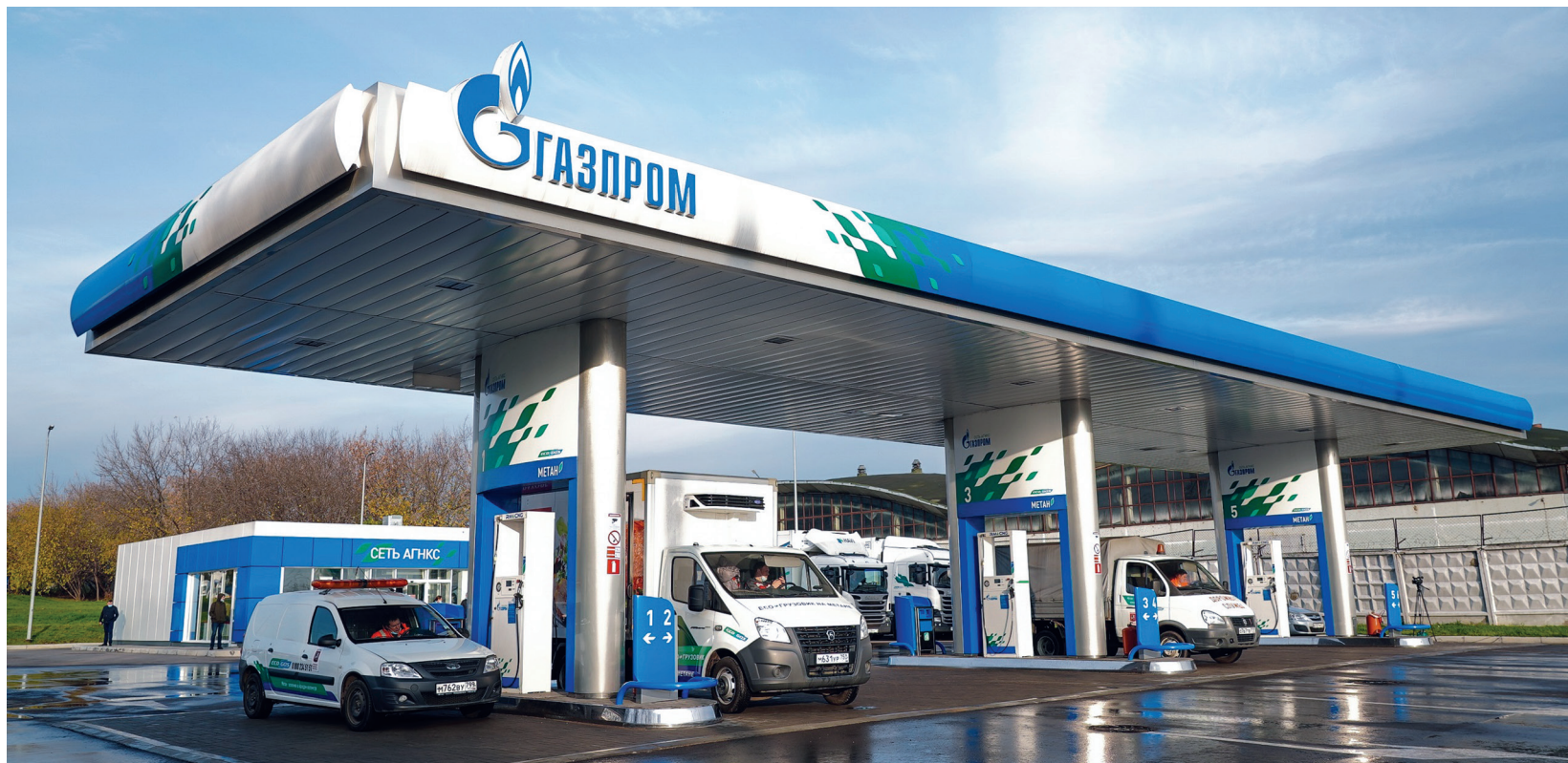
Новая АГНКС «Газпром»
